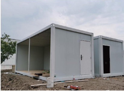
③ 安装墙板 Install Wallboard
